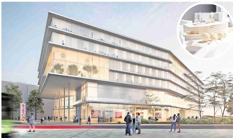
Viel Glas, viel Licht: Das Stuttgarter Büro „haascookzemrich studio 2050“ hat die neue Enercity-Zentrale entworfen.
